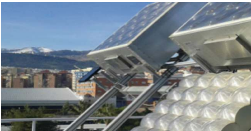
Módulos fotovoltaicos de concentración situados en la terraza de un edificio de la Universidad de Jaén. Foto: UJA
