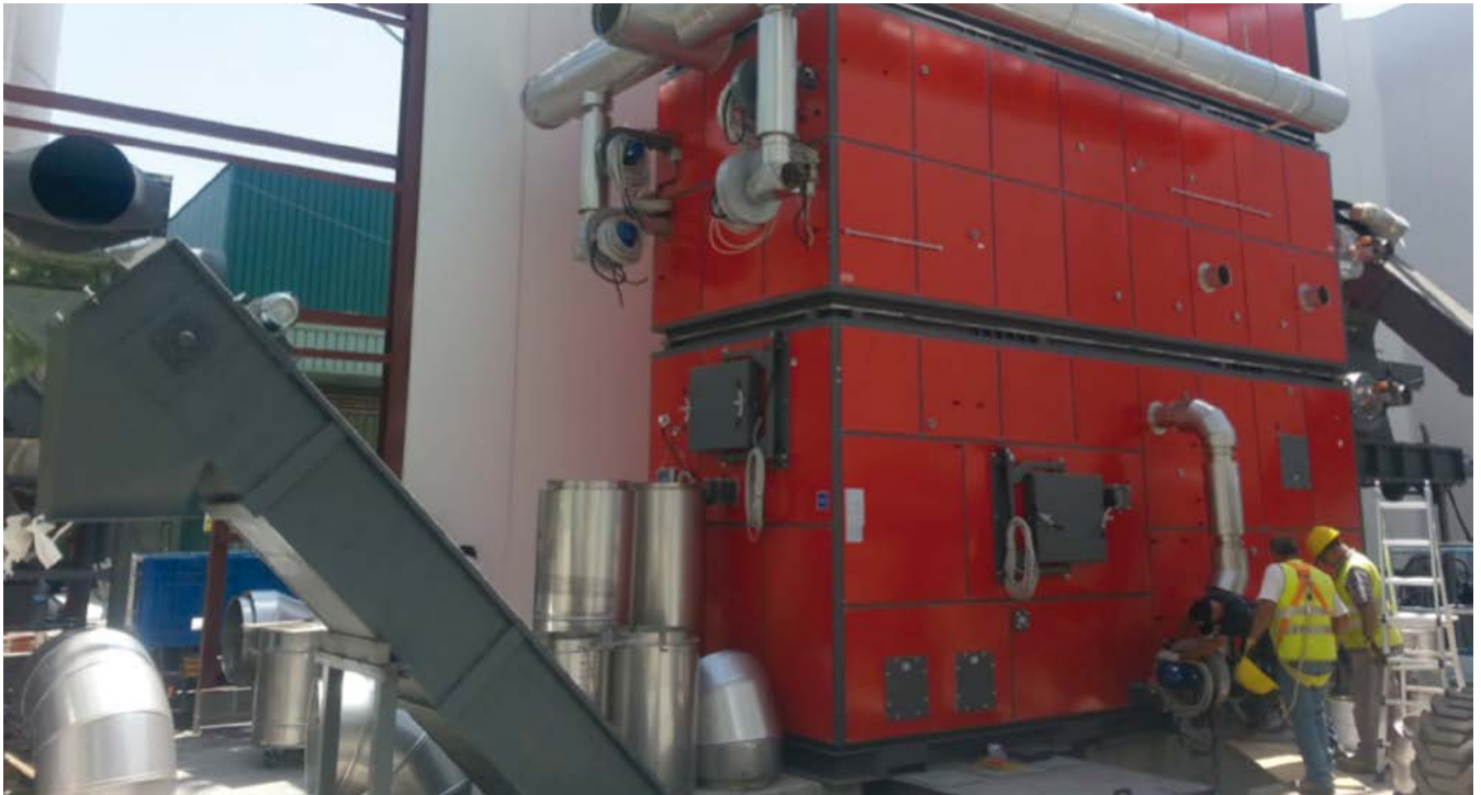
Trabajos de construcción de la caldera.
