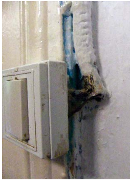
Figura 7. Aislamientos deteriorados.
