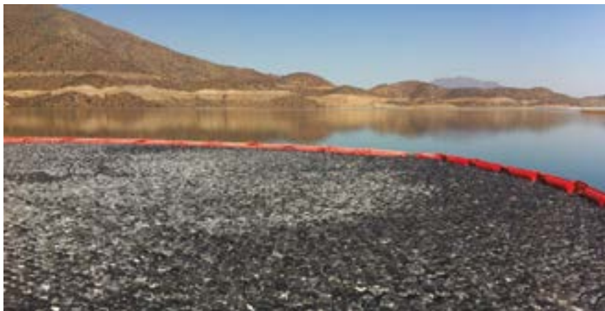
Esferas de polietileno para combatir la evaporación y la sequía. Foto: Exma / Barrier Ball.
