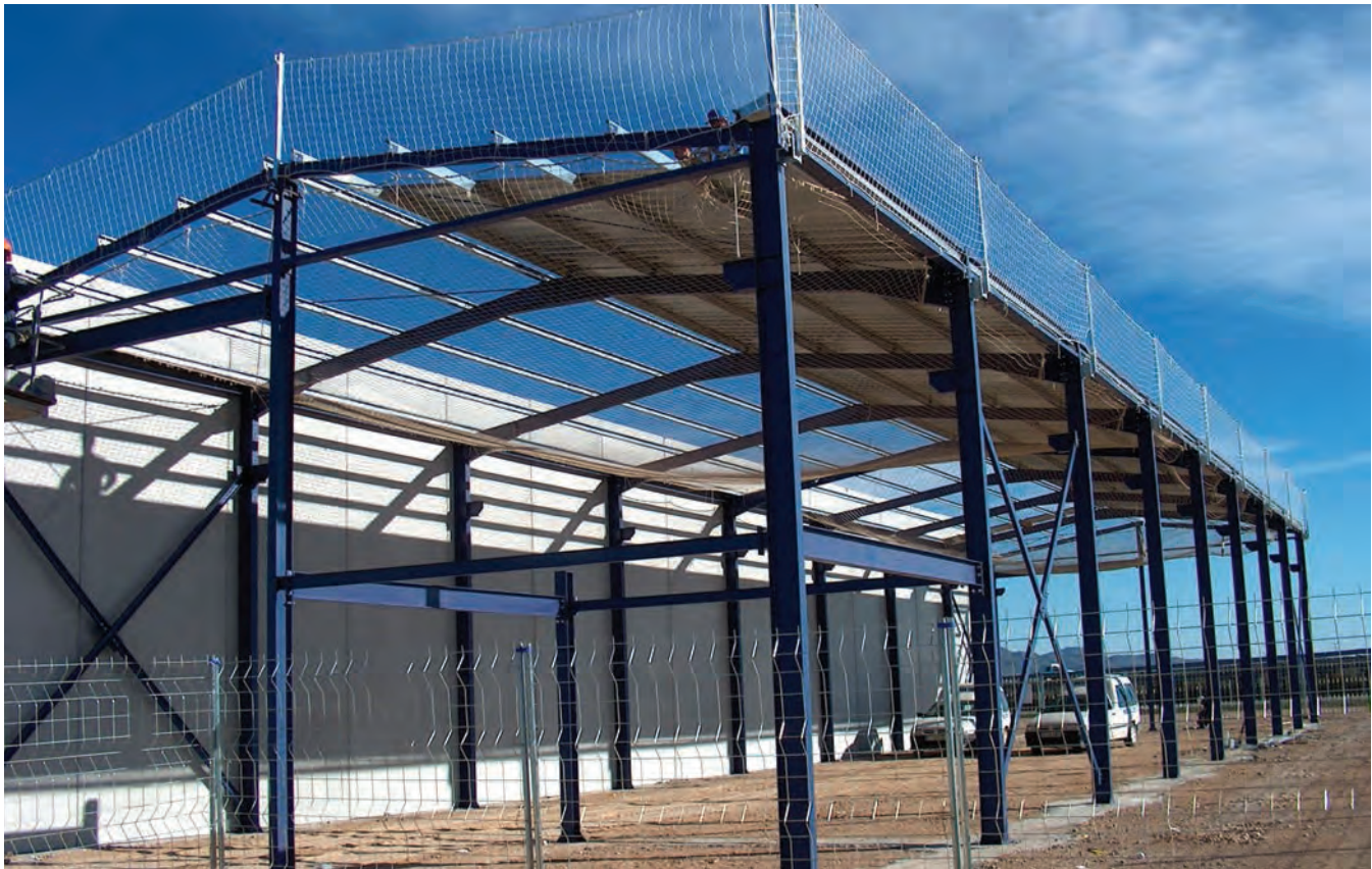
Figuras 3. Obra industrial en la que se ha planificado la seguridad para ejecutar los trabajos con protección colectiva.
