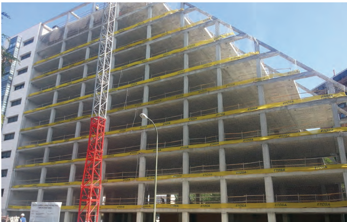
Figura 4. Obra de edificación en la que se ha planificado la seguridad para ejecutar los trabajos con protección colectiva.
