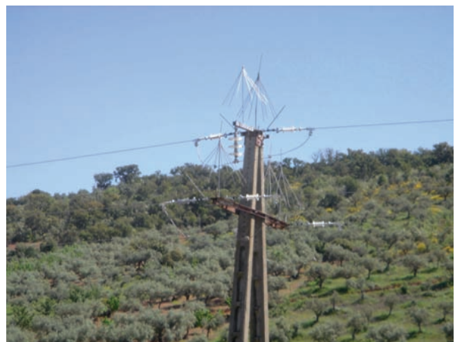
Figura 12. Montaje de alargadera y antena.
