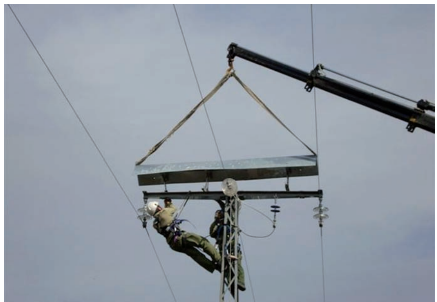
Figura 21. Instalación del tejadillo.
