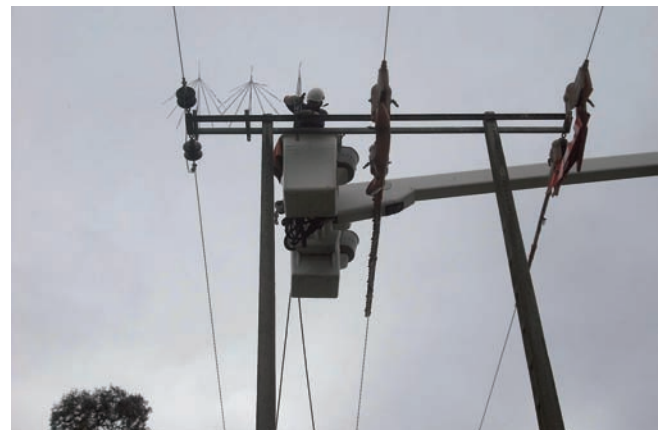
Figura 16. Instalación sistema antiposada tipo paraguas.
