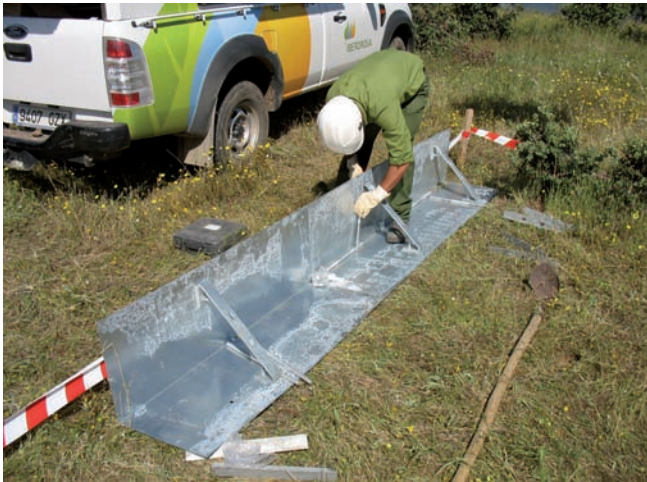
Figura 18. Tejadillo (en fase de montaje).
