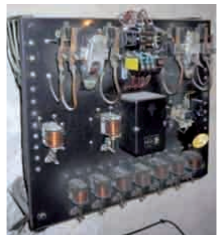
Figura 9. La primera imagen muestra una botonera antigua para puerta exterior con un solo pulsador de llamada y sin ningún tipo de luminosos que indique el estado del ascensor. La segunda imagen muestra un sistema de control básico para ascensores utilizado el siglo pasado.
