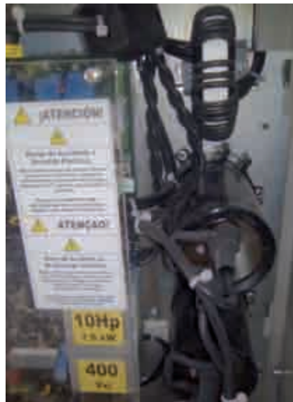
Figura 11. Variador de la marca Mac Puarsa en el que se pueden observar los filtros y condensadores utilizados para atenuar las radioperturbaciones e interferencias.
