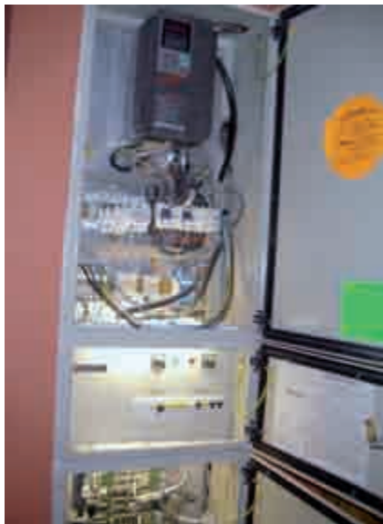
Figura 10. Maniobra inteligente de marca Rotelec que optimiza y controla la gestión de las llamadas con la regulación de velocidad del motor a través de un convertidor de frecuencia marca Fuji.
