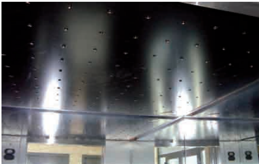
Figura 8. Podemos observar un techo de cabina iluminado con LED independientes.
