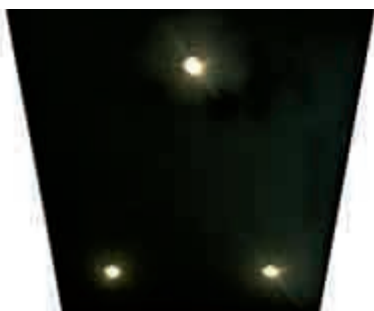
Figura 6. Techo de cabina de ascensor con tres lámparas halógenas sobre bandeja abatible negra. Estas lámparas son fácilmente sustituibles por otras de tecnología LED o por lámparas de bajo consumo tipo fluorescentes compactas.
