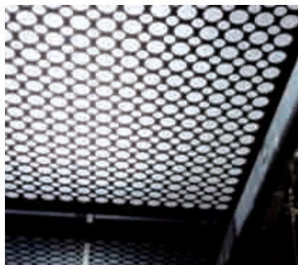
Figura 7. Podemos observar una iluminación de cabina por equipos fluorescentes. En la imagen de la izquierda, los equipos están cubiertos por una bandeja abatible negra de chapa perforada con metacrilato blanco opal, y en la de la derecha, por un techo de cristal laminar que descansa sobre un marco metálico de acero inoxidable.
