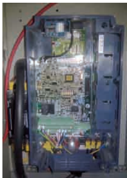
Figura 12. Interior de un variador de marca Fuji.
