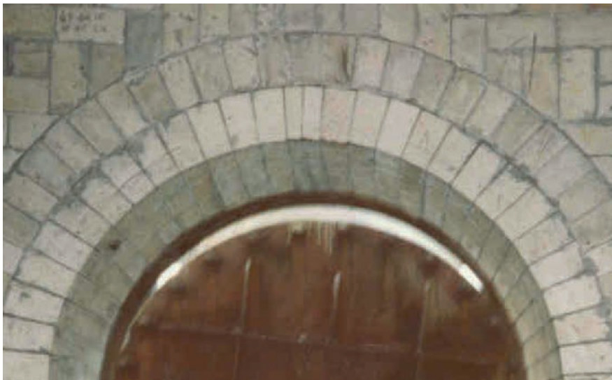
Figura 1. Doble arco construido con material refractario en un horno industrial.
