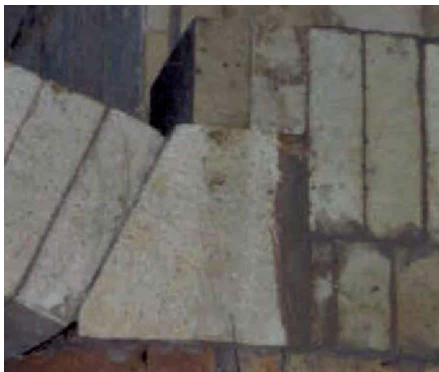
Figura 4. Apoyo de salmer en paredes. Salmer normalizado. Obsérvese que en este caso el apoyo del salmer no es otro que la propia pared.
