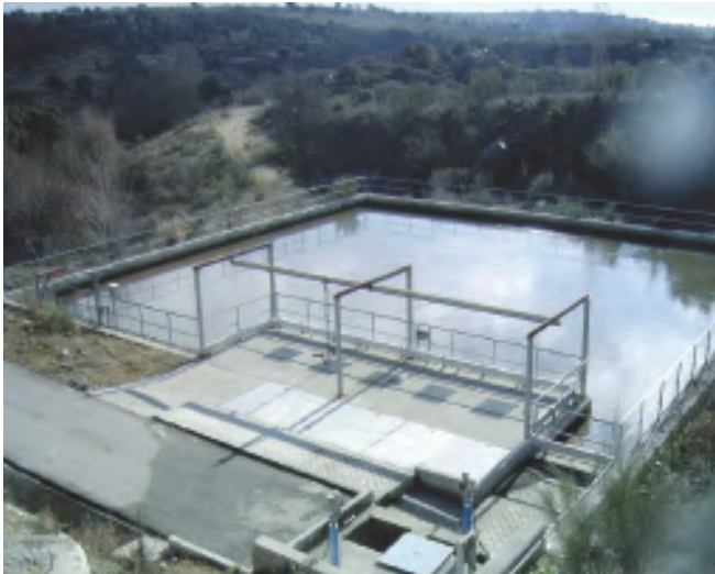
Figura 1. Depósito de mezcla y homogeneización de una planta de fangos.
