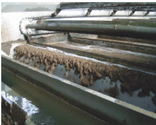
Figura 5. Separación de lodo y agua en el flotador.
