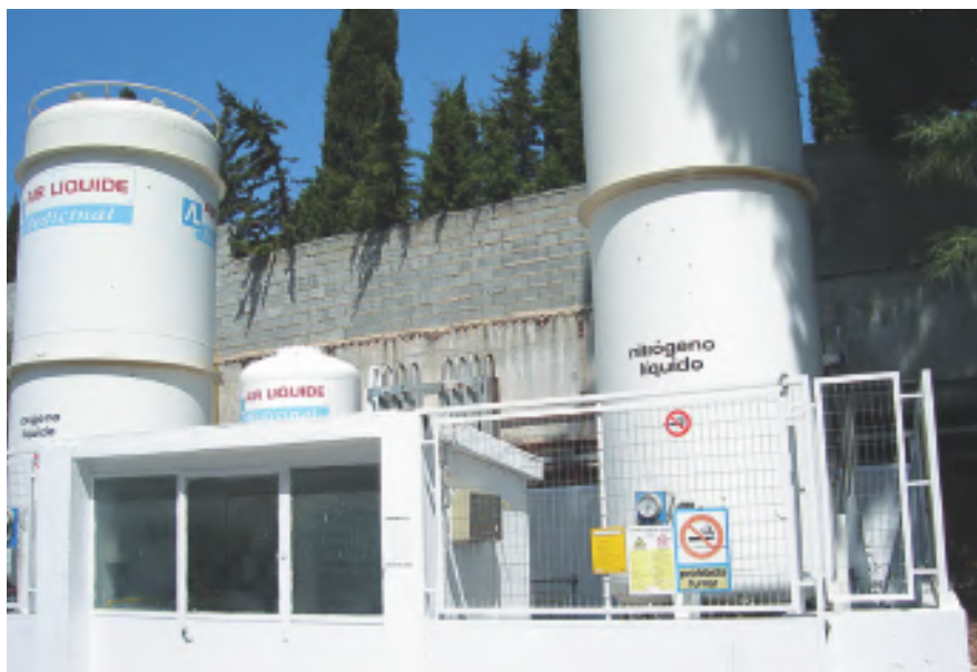
Figura 1. Almacenamiento exterior de nitrógeno líquido.
