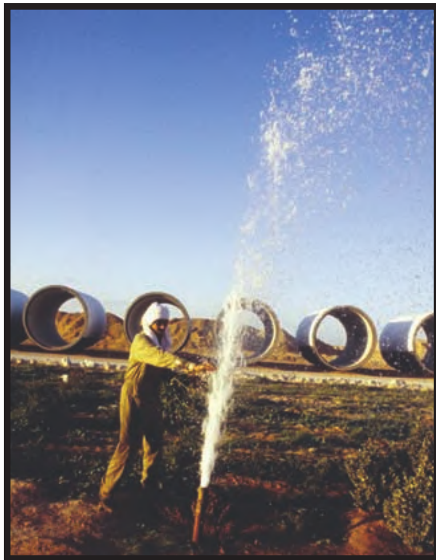
Surtidor de agua en las obras de construcción del Gran Río Artificial en Libia. Foto: Akwa Betote
