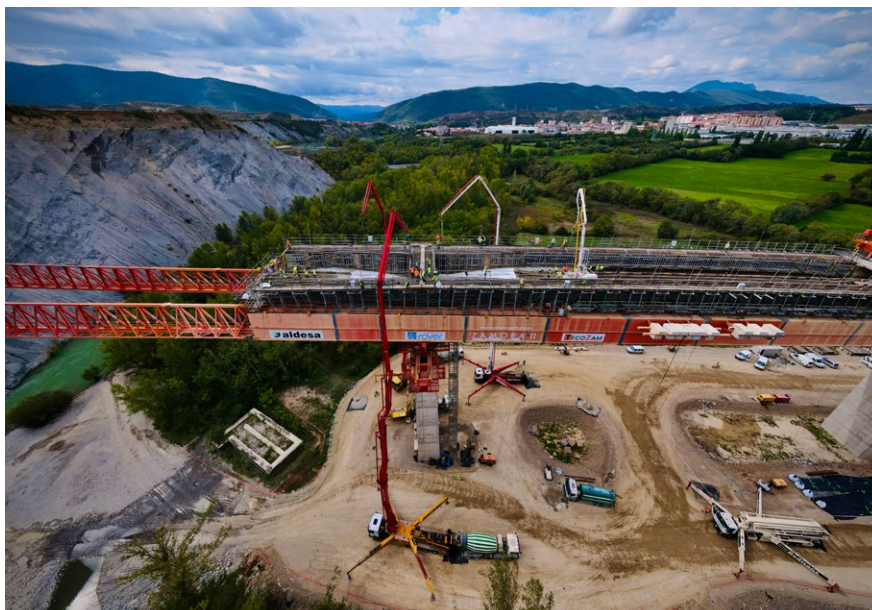
Operaciones de hormigonado de vano construido mediante la técnica de autocimbra MSS 90 Zamora II.
