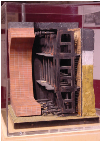
Maqueta del escudo tunelador de Marc Brunel, en el Museo Brunel de Rotherhithe (Londres). Fuente: Dunks58 en English Wikipedia. Dominio público, vía Wikimedia Commons.
