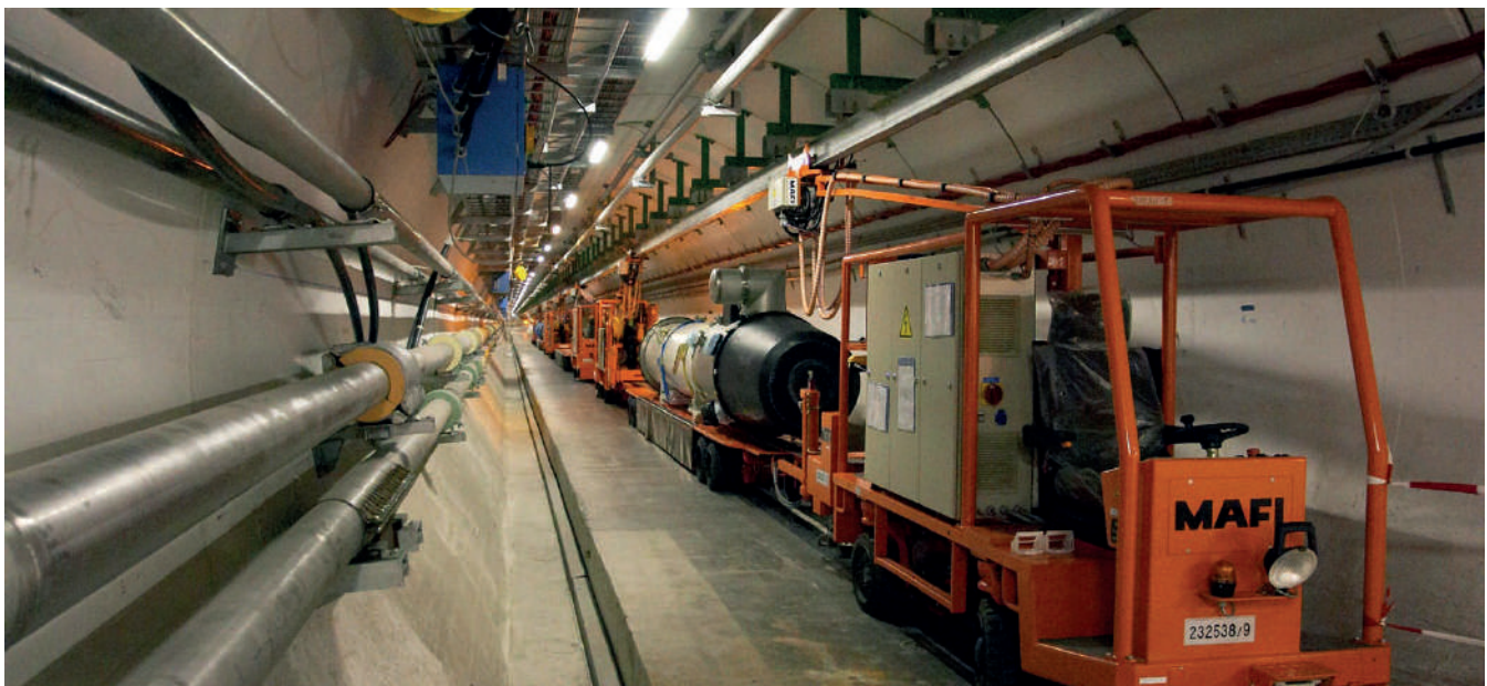
Túnel del antiguo gran colisionador de electrones y positrones del CERN donde se encuentra en la actualidad el gran colisionador de hadrones (el mayor del mundo). Fuente: Wikimedia Commons/ Juhanson /CC BY-SA 3.0.
