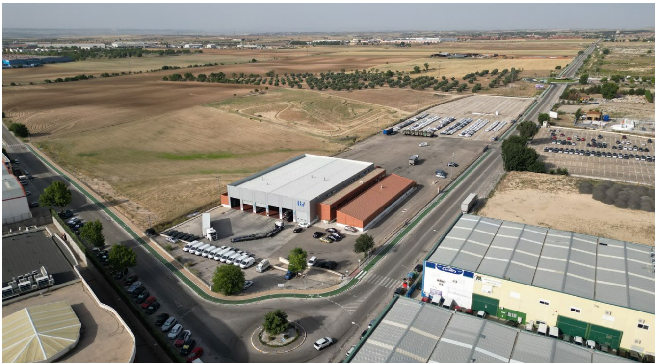
Figura 1. Estación de Inspección Técnica de Vehículos. (Imagen cedida por los autores del artículo).
