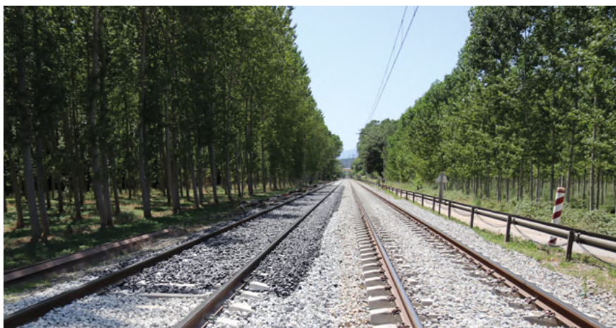
Figura 3. Tramo de pruebas de Neoballast en línea de ADIF entre Caldes y Maçanet Massanes.
