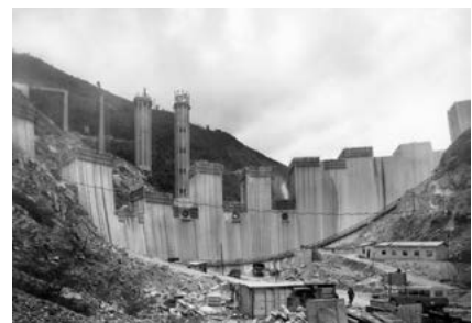
Figura 2. Otra perspectiva de la construcción de las torres de toma de captación de agua y de los diferentes bloques de hormigón de la presa de Susqueda (Fundación Endesa).
