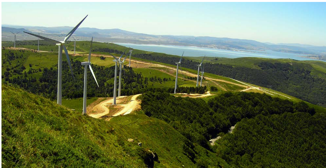
Parque eólico de Valdeporres (Burgos). Foto: Iberdrola.
